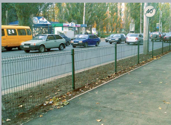
Пешеходное ограждение на ул. Дзержинского. г. Тольятти, Россия.
