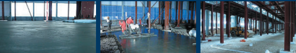
Покрасочный корпус для АвтоВаз-Рено Тольятти / РФ (бесшовные полы 28 000 м², Hendix prime 75/52 – 50 кг/м³, толщина пола 170 мм)
