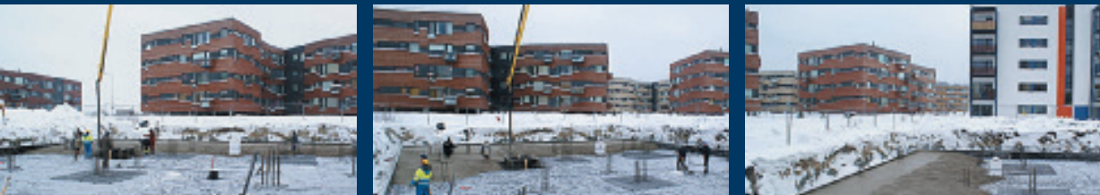
Несущий фундамент для 6-этажного жилого дома №4, на улице Идапуллу в г. Таллин/Эстония (несущая фундаментная плита 600 м², Hendix prime 75/52 – 60 кг/м³, толщина фундамента 600 мм)
