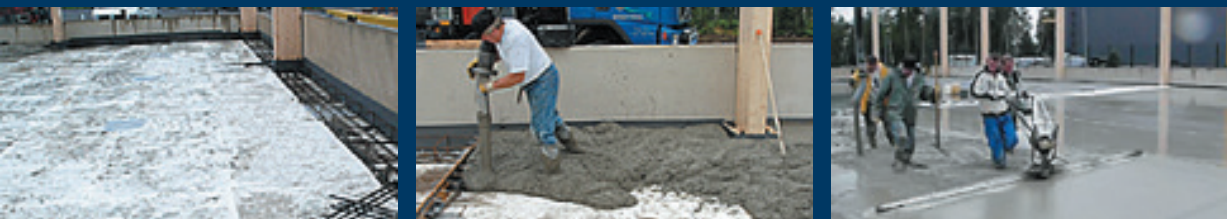
Логистический центр в г. Коккола/Финляндия (полы на сваях 1 230 м², Hendix prime 75/52 – 40 кг/м³, толщина пола 200 мм)
