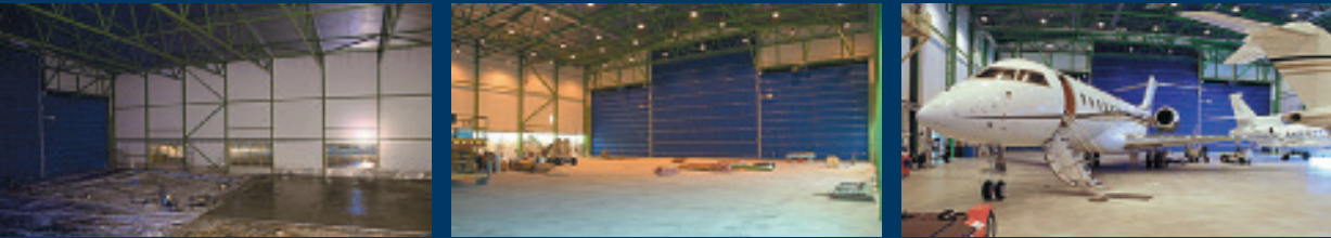
Ангар для стоянки и ремонта самолетов Airbus A319 в аэропорту Вантаа/Финляндия (бесшовные полы 2100 м², Hendix 1/50 – 45 кг/м³, толщина пола 150 мм)
