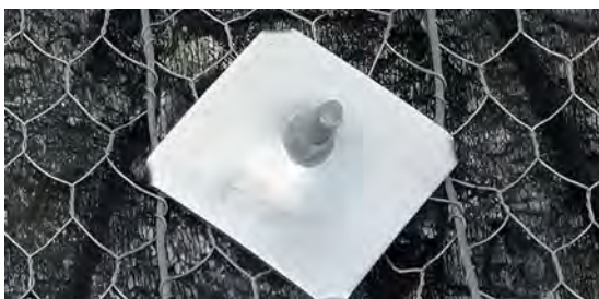
Анкер с прижимной пластиной
