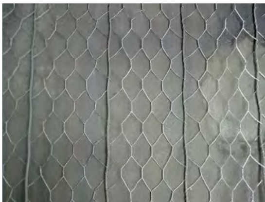
Высокопрочные канаты объединенные сеткой двойного кручения
