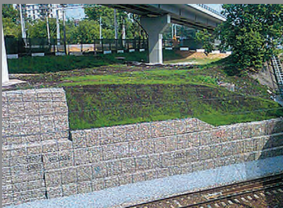
Реконструкция развязки ЖД и автодорог. Московская область, Россия.
