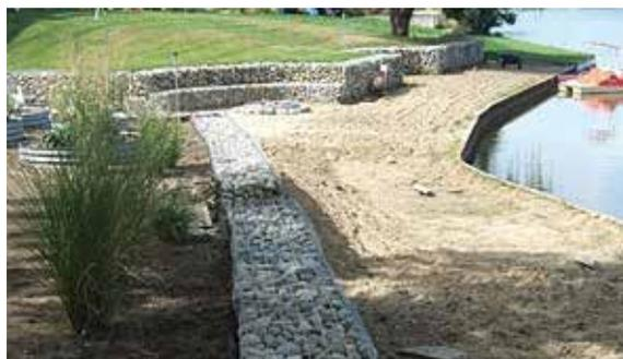
Для наполнения сварных габионов рекомендуется использовать гранитный щебень, бутовый камень, булыжник, гальку или кусковое цветное стекло с фракцией камня: 40÷60 мм (мелкая), 70÷150 мм (средняя) или 100÷250 мм (крупная) в зависимости от размера ячейки карты габиона.
