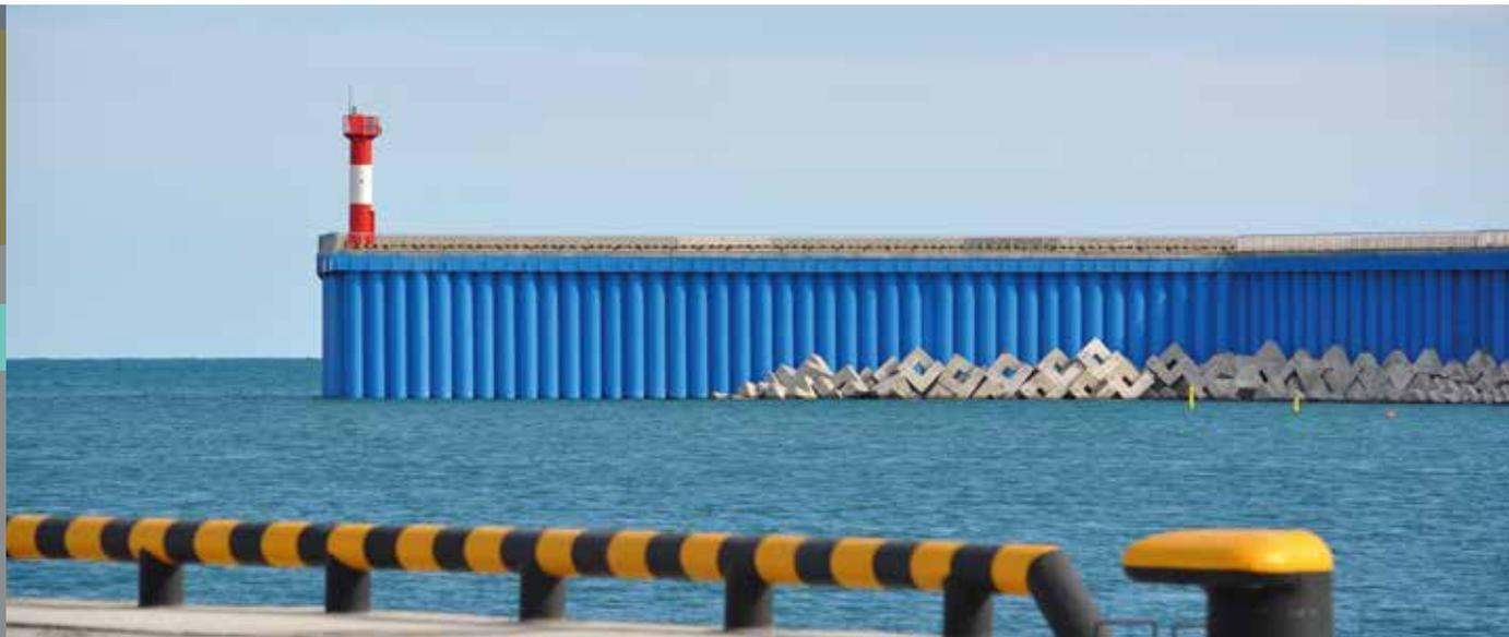
Основное применение замковых соединений – **шпунт трубчатый сварной (ШТС)**. Также, замковое соединение Северсталь-метиз применяется для других типов сварных шпунтовых панелей (плоских, корытных и др.).
