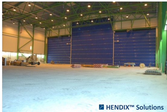
Ангар для стоянки и ремонта самолетов Airbus A319 в аэропорту Вантаа/Финляндия (бесшовные полы 2 100 м 2 , Hendix 1/50 – 45 кг/м 3 , толщина пола 150 мм)
