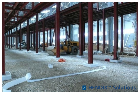
Покрасочный корпус для АвтоВаз-Рено Тольятти / РФ (бесшовные полы 28 000 м 2 , Hendix Prime 75/52 - 50 кг/м 3 , толщина пола 170 мм)
