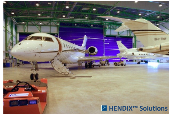
Ангар для стоянки и ремонта самолетов Airbus A319 в аэропорту Вантаа/Финляндия (бесшовные полы 2 100 м 2 , Hendix 1/50 – 45 кг/м 3 , толщина пола 150 мм)
