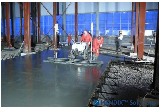
Покрасочный корпус для АвтоВаз-Рено Тольятти / РФ (бесшовные полы 28 000 м 2 , Hendix Prime 75/52 - 50 кг/м 3 , толщина пола 170 мм)
