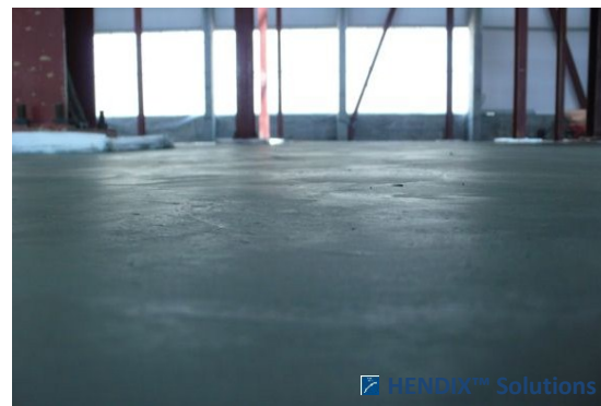
Покрасочный корпус для АвтоВаз-Рено Тольятти / РФ (бесшовные полы 28 000 м 2 , Hendix Prime 75/52 - 50 кг/м 3 , толщина пола 170 мм)
