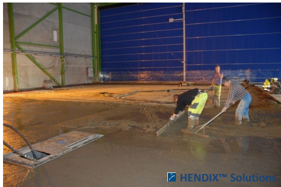
Ангар для стоянки и ремонта самолетов Airbus A319 в аэропорту Вантаа/Финляндия (бесшовные полы 2 100 м 2 , Hendix 1/50 – 45 кг/м 3 , толщина пола 150 мм)
